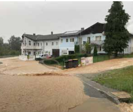
Das Hochwasser in Wolfpassing
